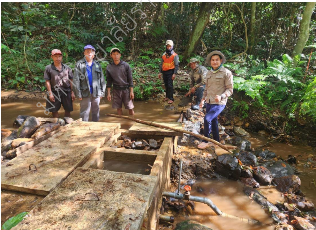
ภาพประกอบ 69 ผู้วิจัยตรวจสอบเยี่ยมใสสถานที่ก่อสร้างต้นน้ำริน
