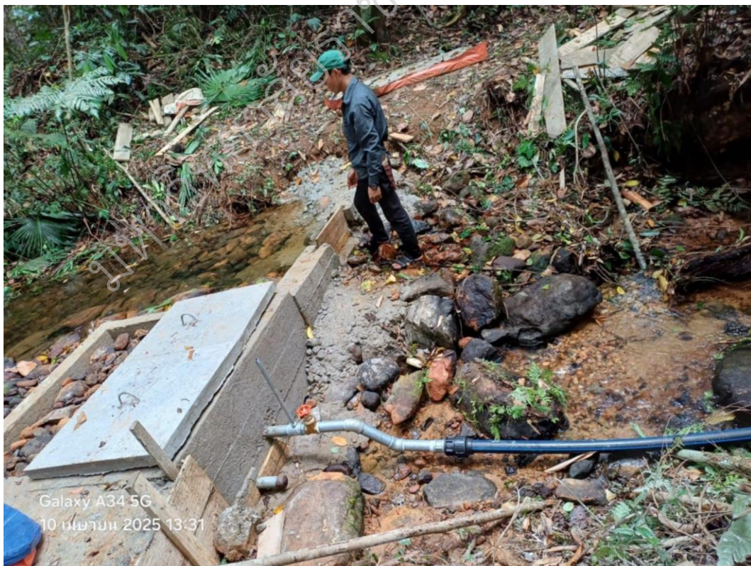
ภาพประกอบ 67 เจ้ากำลังก่อสร้างติดตั้งระบบน้ำริน
