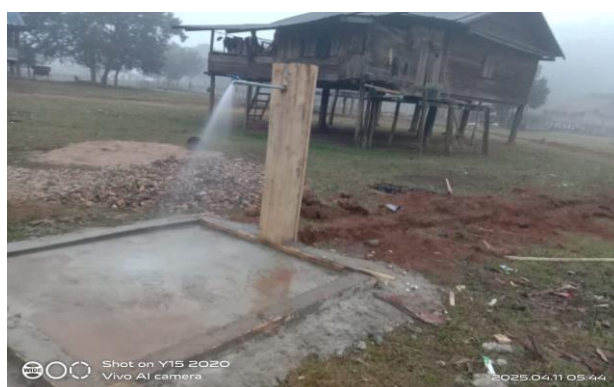
ภาพประกอบ 10 ระบบน้ำริน (ประปาภูเขา) บ้านกอบง เพื่อการอุปโภคและบริโภค ในชุมชน
