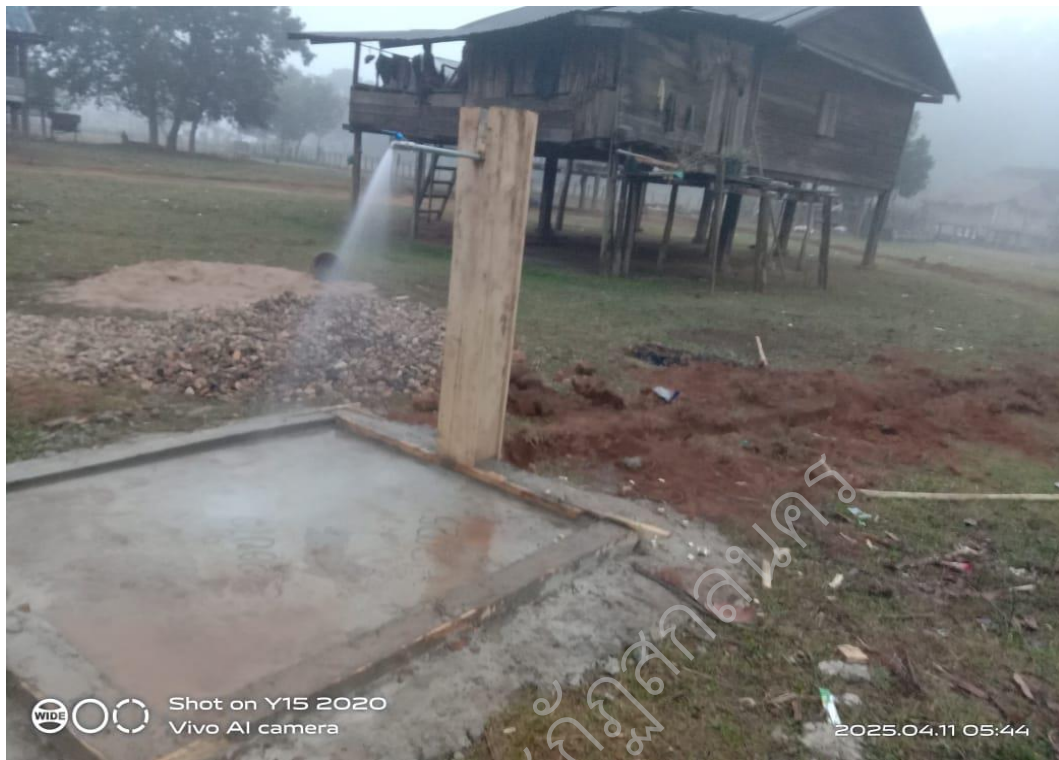
ภาพประกอบ 74 สถานที่ปล่อยน้ำรินสร้างเสร็จ และใช้ในชุมชน
