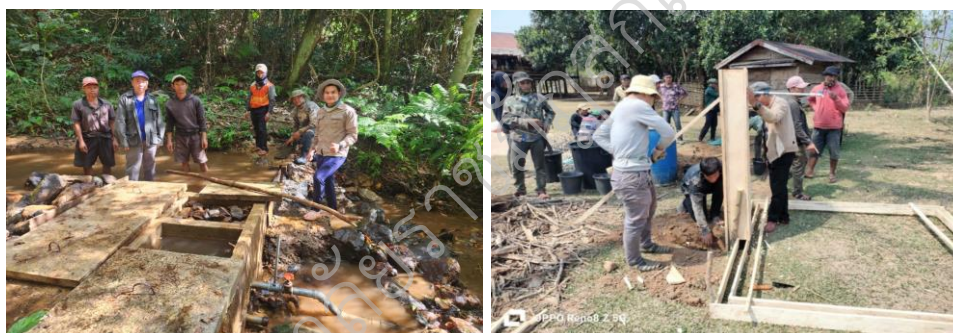
ภาพประกอบ 9 การก่อสร้างและติดตั้งระบบน้ำริน
