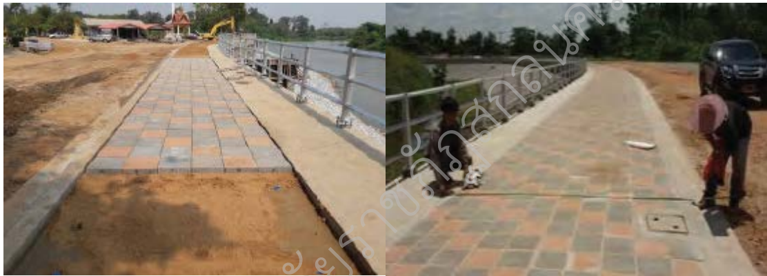
ภาพประกอบ 21 การก่อสร้างพื้นทางเท้าและคันหิน ค.ส.ล. ด้านหลังเขื่อน
