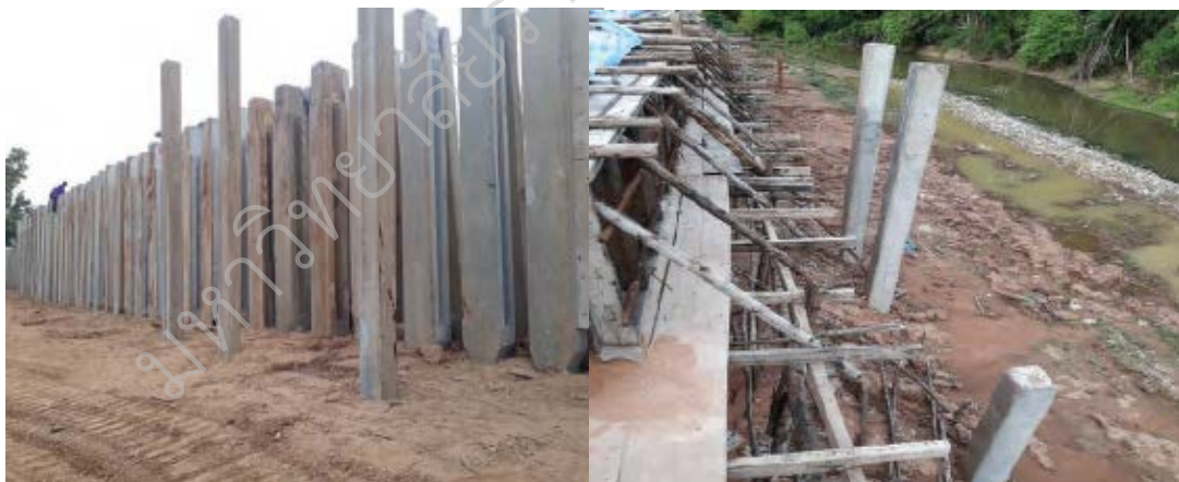
ภาพประกอบ 12 การตอกเสาเข็มรับโครงสร้างบันไดหน้าเขื่อน
