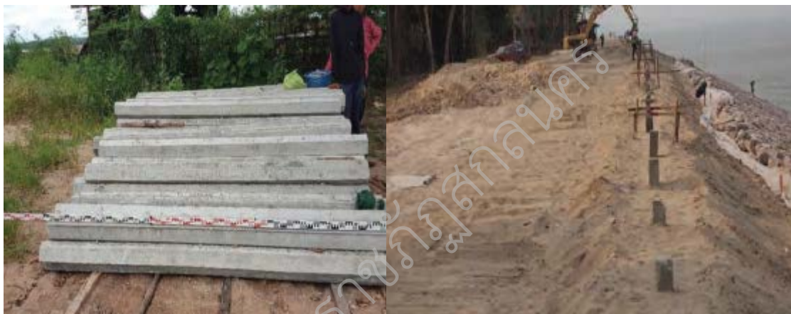
ภาพประกอบ 15 เสาเข็มสั้น ยาว 2.50 เมตร และตำแหน่งเสาเข็มเมื่อตอกแล้วเสร็จ
