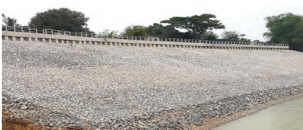
ภาพประกอบ 7 เขื่อนป้องกันตลิ่งแบบเสาเข็มแรงตันทันดิน ถมทรายเรียงหินใหญ่
