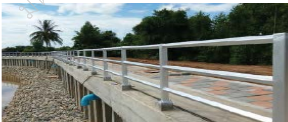
ภาพประกอบ 20 ช่วงรวากันตกทุกช่วงต้องมีระยะห่างระหว่างริมเสาดังถึงริมเสาไม่เกิน 1.50 เมตร
