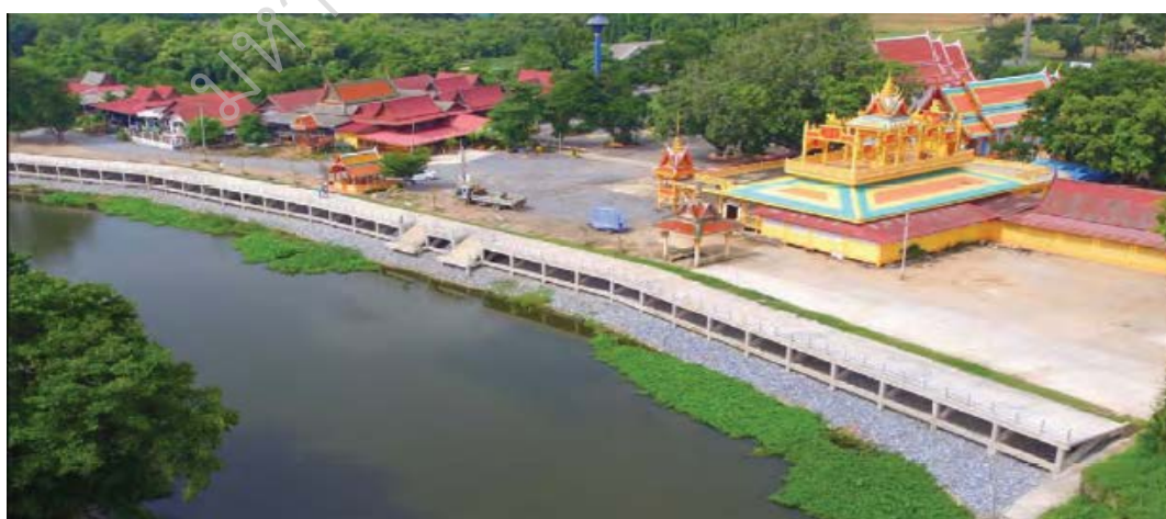
ภาพประกอบ 8 เขื่อนป้องกันตลิ่งแบบมีโครงสร้างลอย
