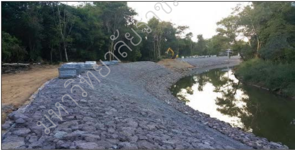
ภาพประกอบ 5 เขื่อนป้องกันตลิ่งแบบถมทรายปิดทับด้วยกล่องลวดตาข่ายแมทเทรล ที่มา : สถาบันพัฒนาบุคลากรด้านการพัฒนา (2561)
