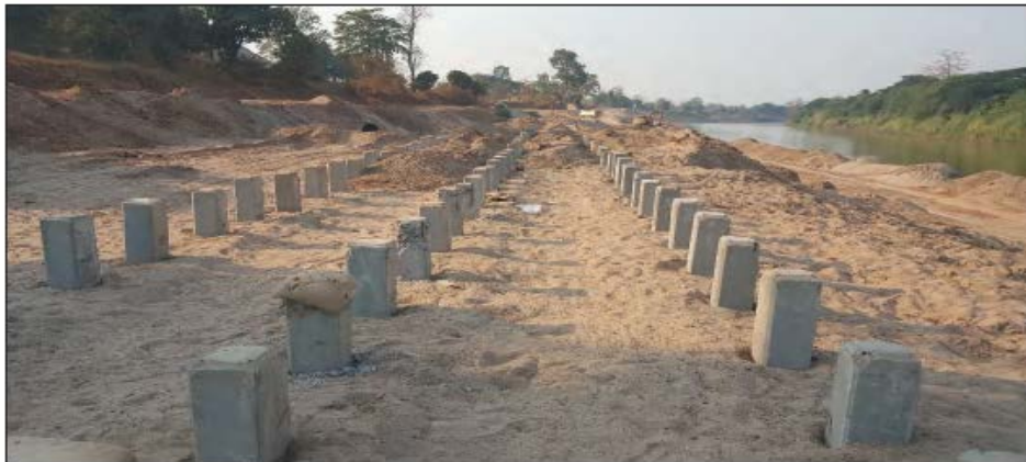
ภาพประกอบ 3 เชื้อนป้องกันตลิ่งแบบถมทรายเรียงหินหน้าเชื้อน และมีเสาเข็มเสริมกำลังดิน
