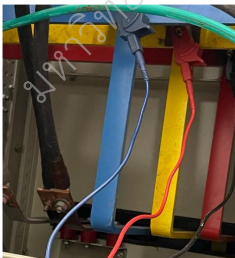
ภาพประกอบ 24 การเก็บรวบรวมข้อมูลระบบไฟฟ้า ของอาคาร 19 มหาวิทยาลัยราชภัฏ สกลนคร ขนาด 30 KW ในสภาวะดีสชาร์จของระบบอินพลังงานไฟฟ้าให้กับระบบไฟฟ้า Vehicle to Grid แบบ 3 เฟส ของรกร่างไฟฟ้ามหาวิทยาลัยราชภัฏสกลนคร ขนาด 1.2 KW ต่อ 1 เฟส
