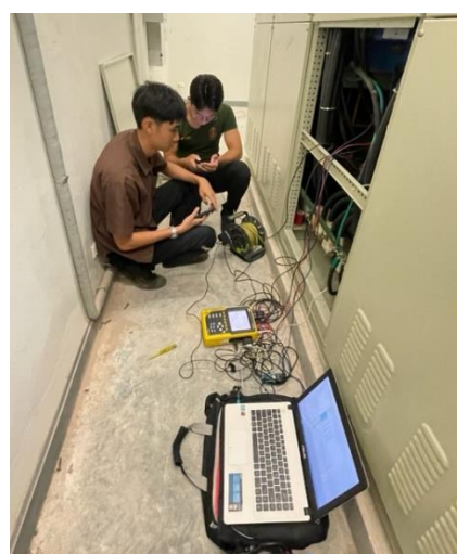
ภาพประกอบ 24 การเก็บรวบรวมข้อมูลระบบไฟฟ้า ของอาคาร 19 มหาวิทยาลัยราชภัฏ สกลนคร ขนาด 30 KW ในสภาวะดีสชาร์จของระบบอินพลังงานไฟฟ้าให้กับระบบไฟฟ้า Vehicle to Grid แบบ 3 เฟส ของรกร่างไฟฟ้ามหาวิทยาลัยราชภัฏสกลนคร ขนาด 1.2 KW ต่อ 1 เฟส
