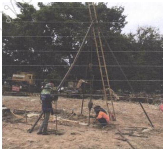
ภาพประกอบ 21 การเจาะสำรวจชั้นดินโครงการก่อสร้างอาคารครุศาสตร์
