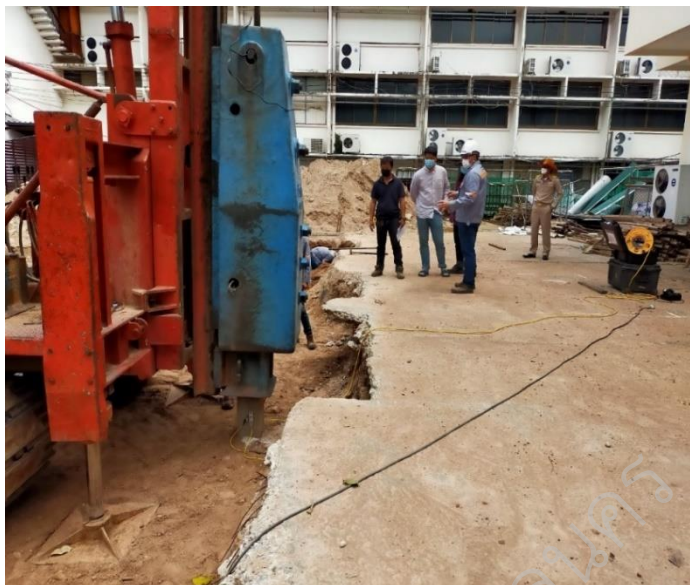
ภาพประกอบ 4 ภาพแสดงการทดสอบเสาเข็มด้วยวิธีพลศาสตร์ (Dynamic load test)
