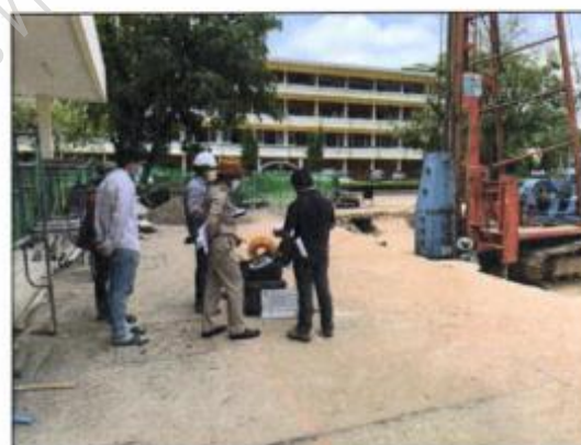
ภาพประกอบ 34 การทดสอบเสาเข็ม
