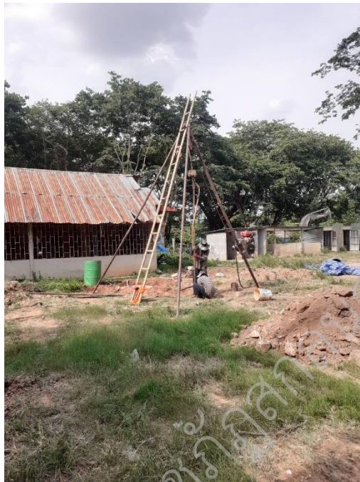
ภาพประกอบ 20 การเจาะสำรวจชั้นดินโครงการเพิ่มประสิทธิภาพระบบประปา
